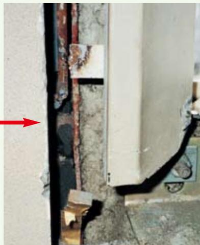
結露防止用吹付け石綿・石綿含有吹付けロックウール（カーテンウォール裏等）
